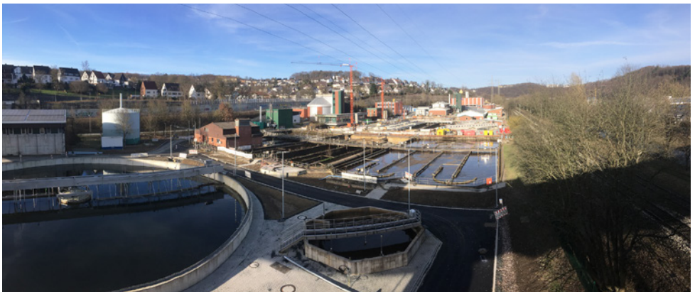
Die Kläranlage Siegen während der umfangreichen Baurbeiten © Hendrik Kölsch
